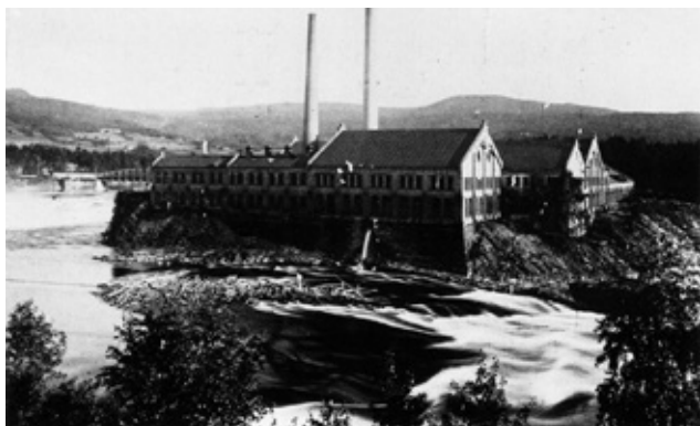
Drammenselven Papirfabrikk. Mange moinger jobbet ved papirfabrikkene.
