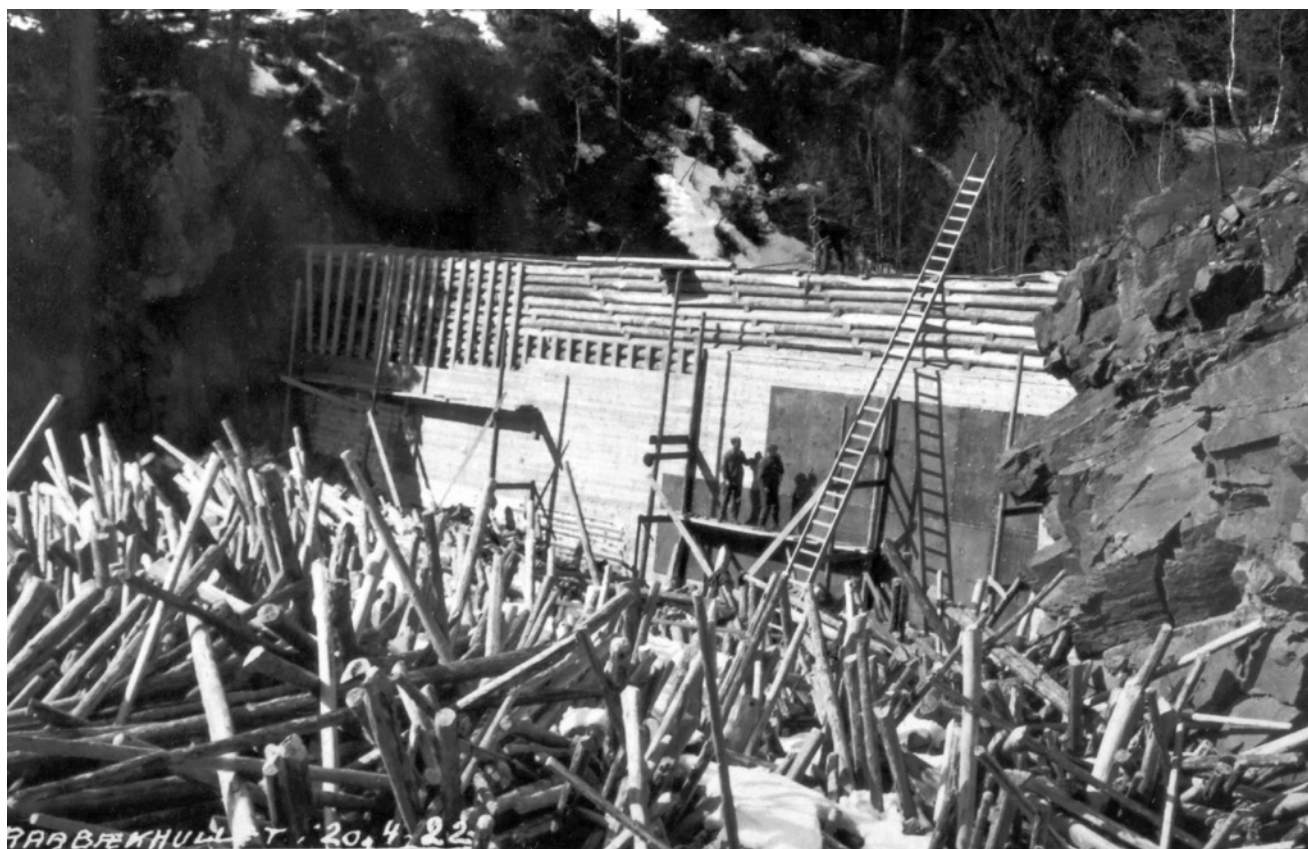
I 1920 ble det bygd ny skådam i Kaggefossen ved Gråbekkens utløp.
