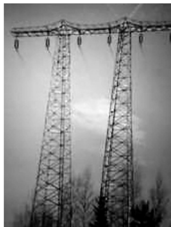
Bildet over viser en av «englemastene» med flere ledningsbyggerer i toppen. I Bakgrunnen ser vi Nore I kraftstasjon.
