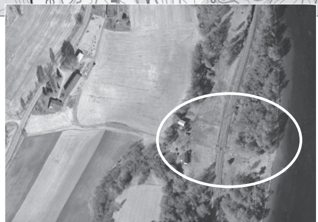
Stoa under østre Hassel. Randfjordbanen skjærer over eiendommen, men det er laget en kulvert for å krysse sporet.
