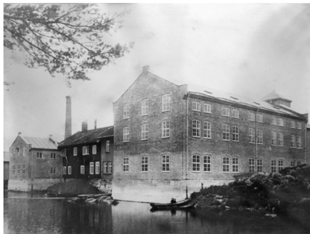
Nybygd veveri etter 1909. I 1909 ble Eriksens foretak omgjort til aksjeselskap. De faste eiendommene ble kraftig belånt, og selskapet satset stort: Veving ble tatt inn som en del av virksomheten. Ny og større fabrikkbygning ble bygd, atskillig maskineri ble anskaffet. Bildet har Ole Torkel Omdal levert.
