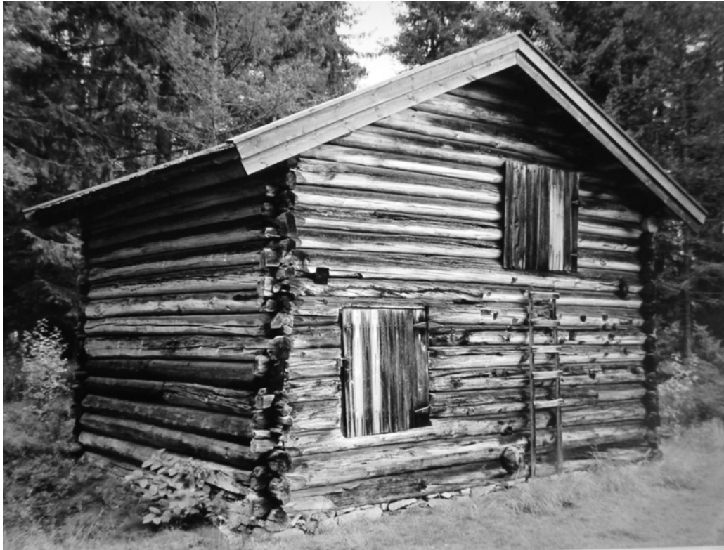
Finnene hadde forskjellige typer tørkeovner. Bildet viser ei finsk rie, som var finnenes tørkehus for svedjerug. Denne ria står nå på Glåmdalsmuseet.
