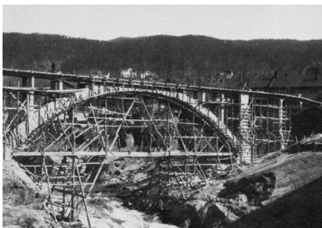
Brua i Embretsfoss under bygging i 1920. Dette var den første betongbrua NSB godkjente for jernbanetraffikk.
