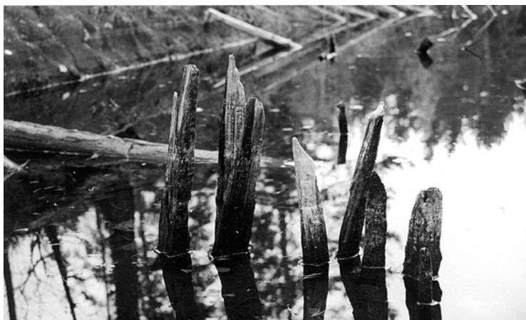
Pelerekken på østsiden av sundet viste at gjerdet dels besto av runde, dels av kløyvde peler. De kløyvde pelene var, så langt en kunne se, mye lik dem en finner som langvøden i skigarder.
