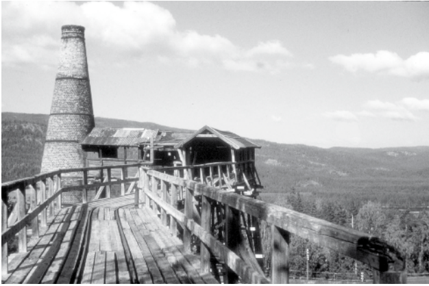
Kjørebrua ut til sjaktovnspipa. Sjaktovnene var en stor sylindrisk ovn med ei pipe vid som ovnen, men som smalnet til vanlig pipe på toppen. Foto: Ottar Jøsang.
