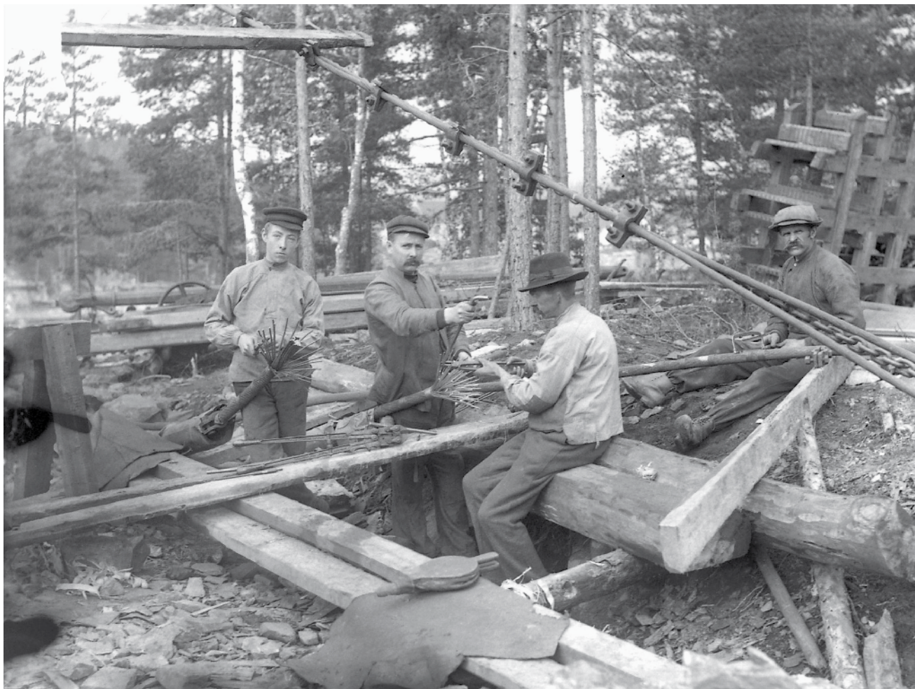
Kabelekspert i arbeid.
