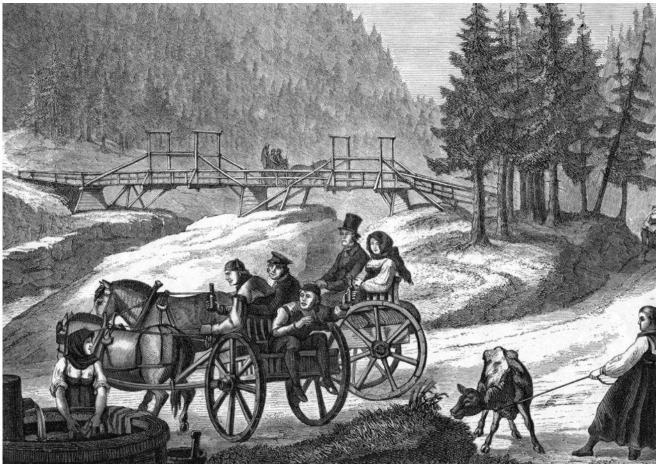
I 1860 ble det etter initiativ fra dr. Thaulow på Modum Bad bygd bru nedenfor Kaggefoss, den såkalte Badebrua. Brua ble sannsynligvis bygd i samarbeid med eieren av Fosnæs gård. Hestene med kjerre er kommet over til vestsiden av elven, altså til Vestre Sponefjerdingen. Veien til Modum Bad sees såvidt i venstre bildekant. Veien på denne siden gikk videre forbi Kaggefoss, Fosnæs og Sandaker fram til storveien ved Amundrud. Gammelt trykk opprinnelig gjengitt i Nordiske billeder med tittelen «Et Vandingssted ved en Skydsstation i Modum Præstegjeld».
