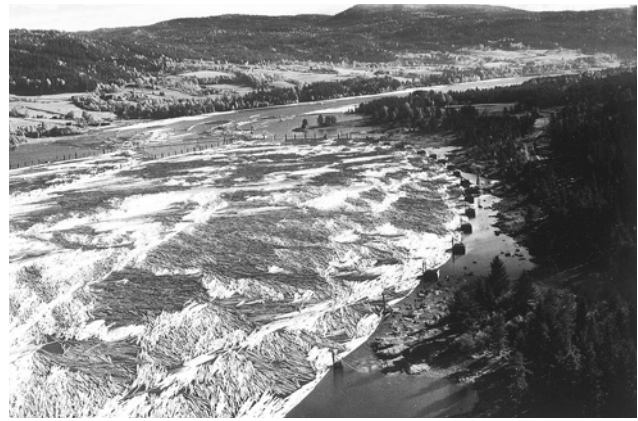
Steinkister og støpte kar langs »Bualandet».
