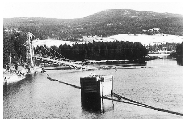
Steinkaret ved Nybrua 1940. Ødeleggelsen av brua er et faktum!
