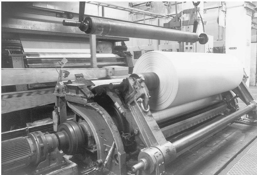
PM 3 – opprulling av ferdig papir på tambur.
