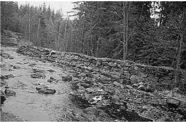
Hundrevis meter av solide steinmurer hindret tømmeret fra å komme på avveie etter brøttingselvene. Bildet er fra Rolia i Holleia.
