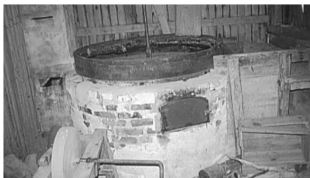
Korntørke med vedfyring fra Kvernbakken mølle, som ble brukt til mølla ble nedlagt.
