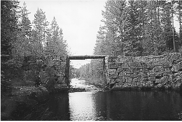
Den mektigste dammen i Holleia er Ulemyrdammen, som er et prektig byggverk og i god stand.
