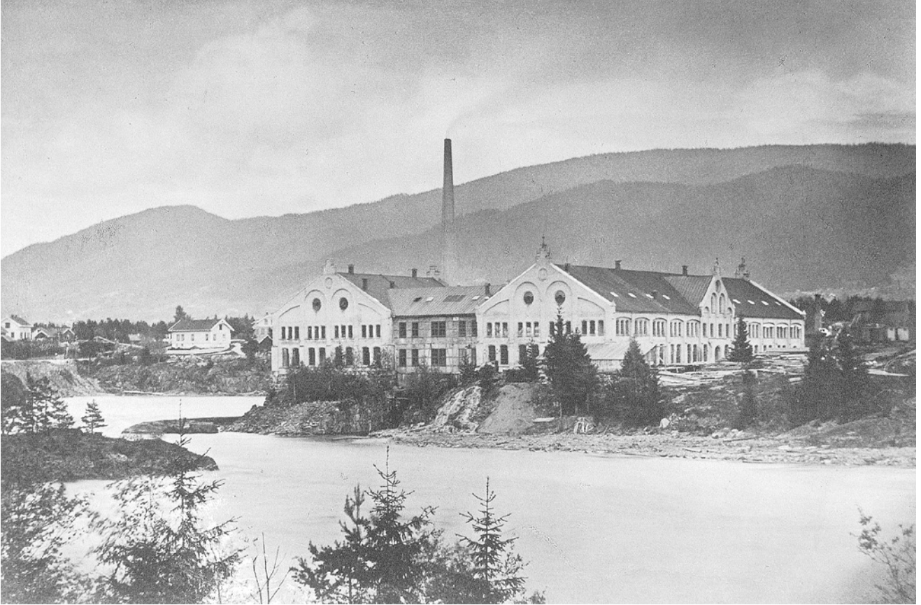
Den opprinnelige fabrikkbygningen på Drammenselven – før brannen i 1889. Bildet er tatt fra Majorud.
