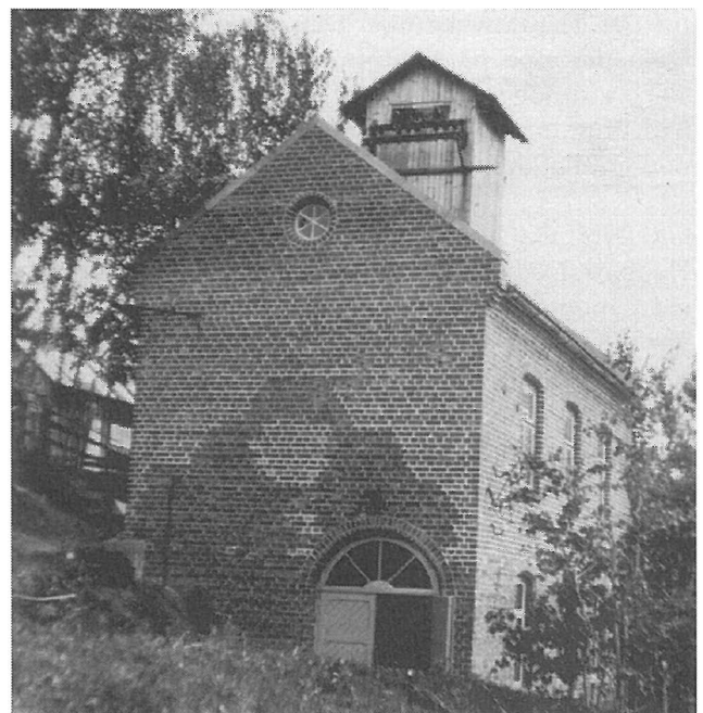
Spone kraftstasjon bygd i 1907.
