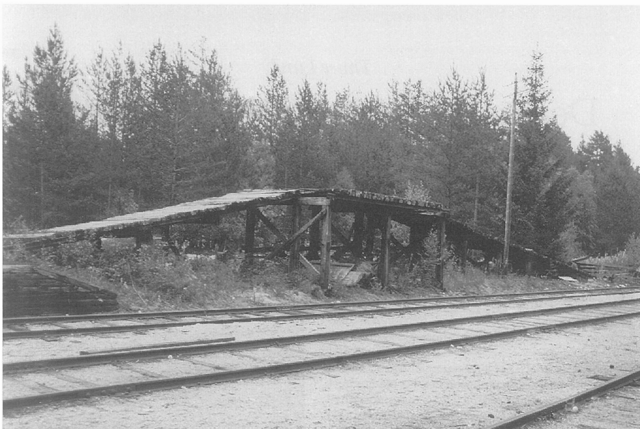
På slike lasteramper ble tømmeret lesset på jernbanevognene. Dette er rampa på Kløtgefoss, som står der ennå.
