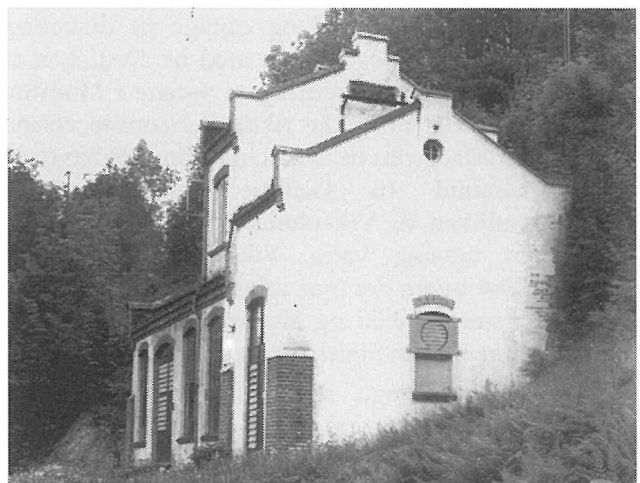
Dyrbak kraftstasjon, bygd i 1912, er i drift ennå.
