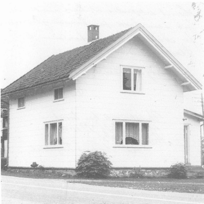
I denne bygningen ved Granum gartneri drev man Fure meieri. Nå er bygningen ominnredet til bolig, og meieridørra mot veien er byttet med et vindu.
