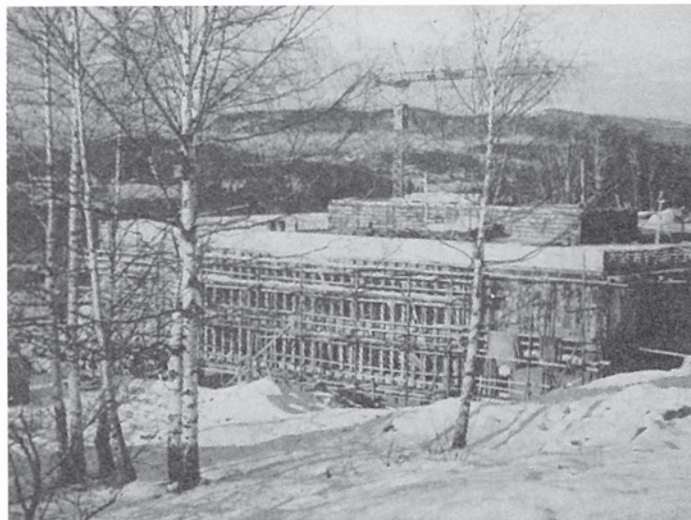
Søndre Modum Ungdomsskole under bygging 1971.
