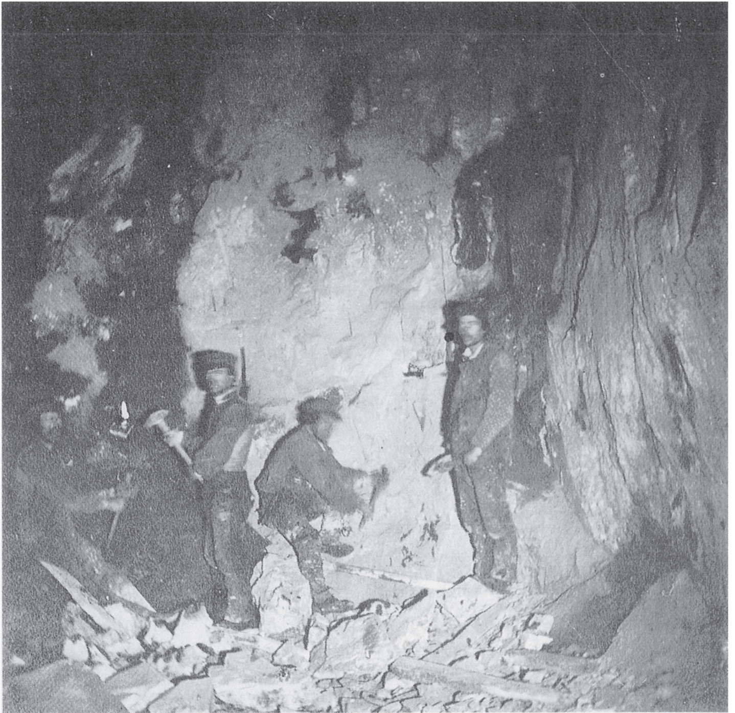
To-manns håndboring inne i gruva.
