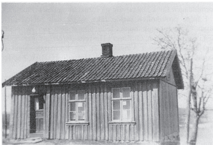
Berg rodestue i Furefjerdingen i bruk som skolehus til 1910.
