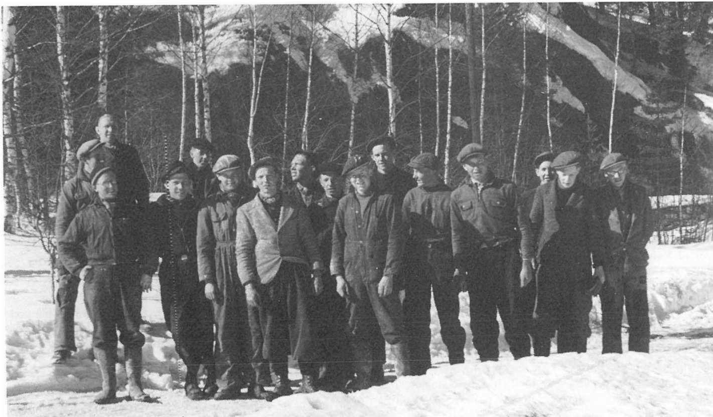
Arbeidsgjengen i 1941, antallet var da økt til 17-18 mann og Karl Ødegaard var formann. Han hadde vært med på restaureringsarbeidet helt fra begynnelsen i 1938 og var altså med som formann under fullførelsen i 1941. Senere stilte han igjen sin store faglige dyktighet til disposisjon for verket da han lot seg engasjere i Stiftelsen Modums Blåfjørveværks restaureringsarbeid. Karl Ødegaard midt på bildet bakerst. Er det noen som kjenner seg igjen?
