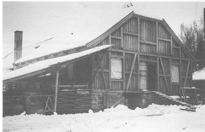
''Nytt hus på gammel grunnmur'', mølla som ble satt opp av Arbeidstjenesten under krigen. Foto av H. Vreim.
