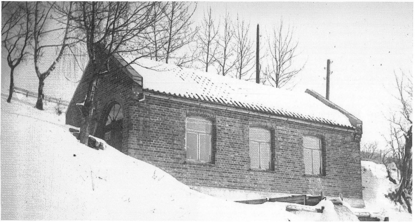
Spone kraftstasjon bygd 1907.
