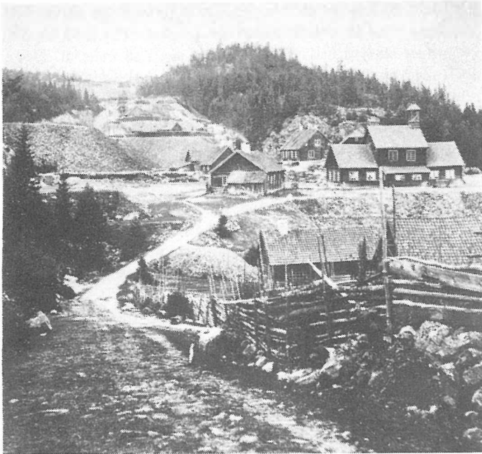
Fra «Gruvetråkka», senteret for gruvedriften. Bildet er tatt fra Skuterudhøiden og viser det karakteristiske skeidehuset til høyre, og bak det skimtes så vidt bergmesterkontoret.
